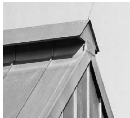
Фото 7.1: Узел соединения конька на фронтоне, высокий вариант
