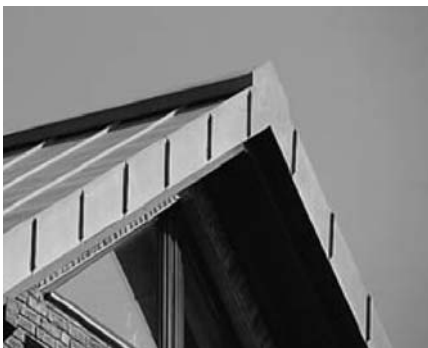
Фото 7.2: Узел соединения конька с ребром, низкий вариант
