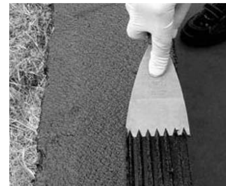
Фото 3.1: Enkolit® наносится гребенчатым шпателем
